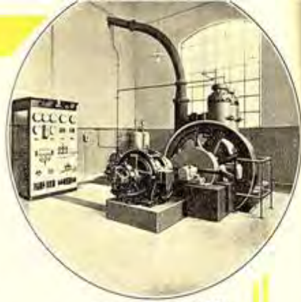
Groupe n° 2, de 150 KVA
