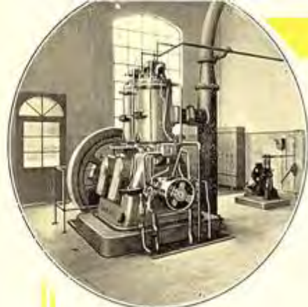
Groupe n° 1, de 150 KVA
