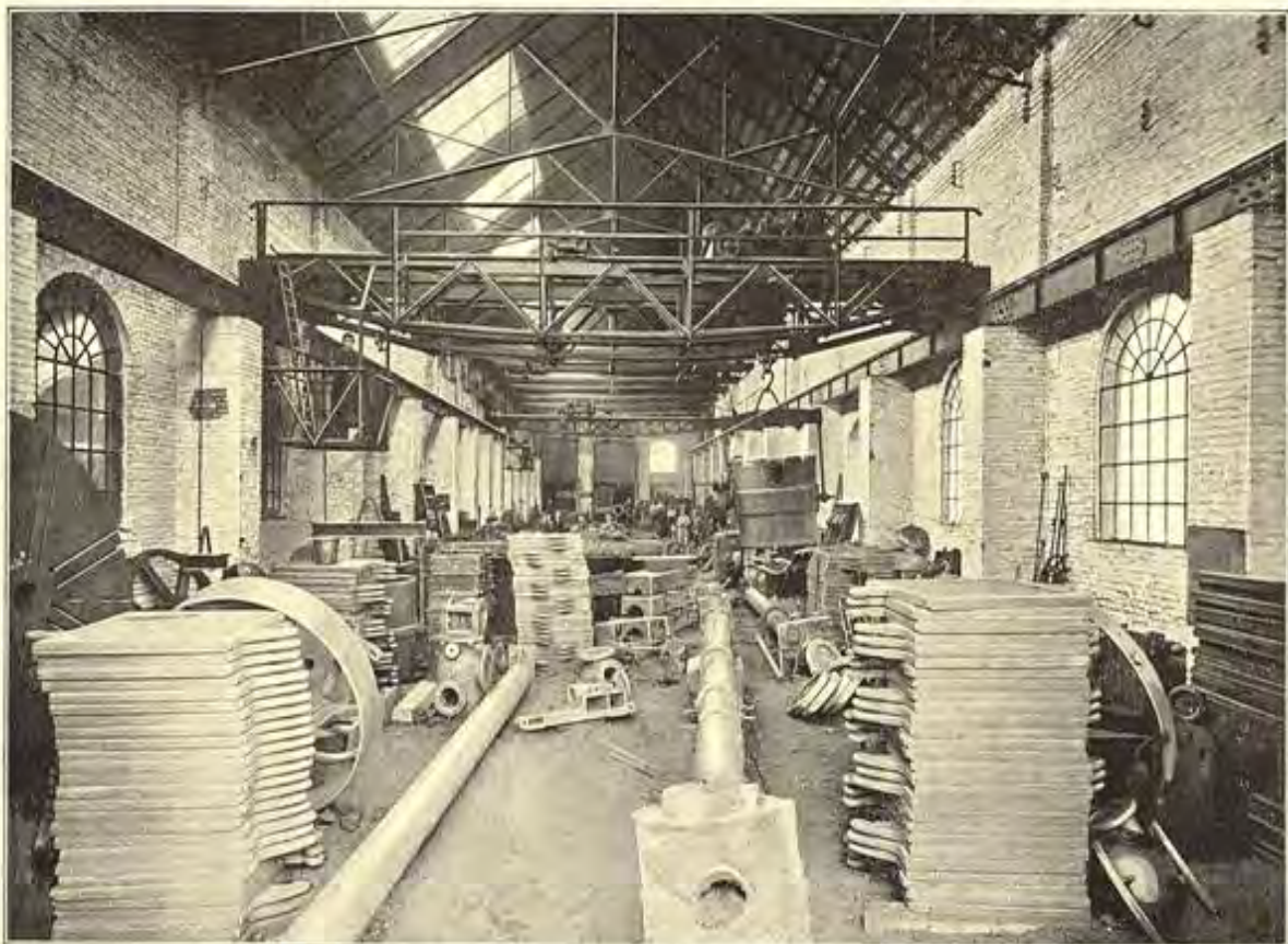
Hall de Fonderie de 15 m 000 sur 80 m 000
