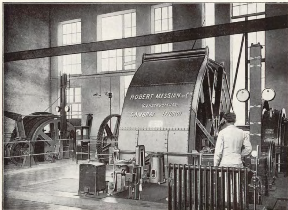
Installation d'une Machine d'extraction électrique à bobines et d'un Treuil de fonçage électrique à tambour à la C ie des Mines de Douchy.
